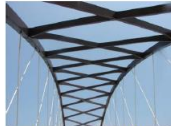
Fig. 5 – Rib Bracing
