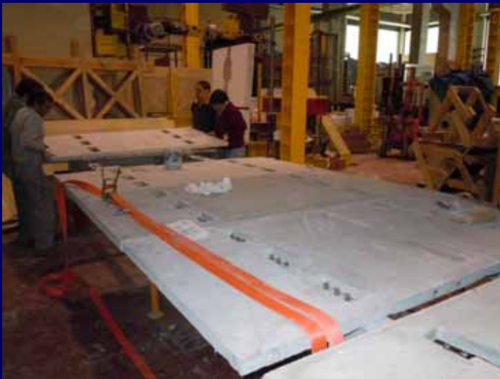
6. Colocação/colagem das lajetas
