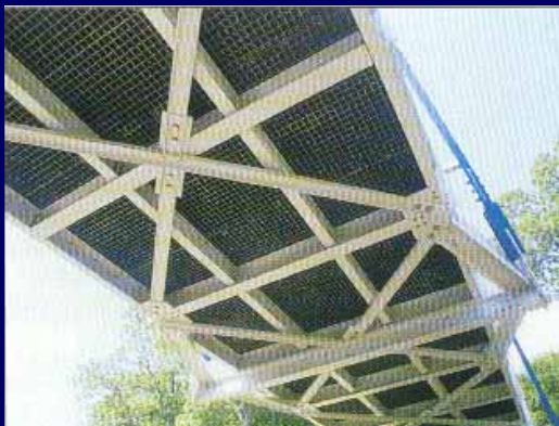
Vista inferior da ponte
