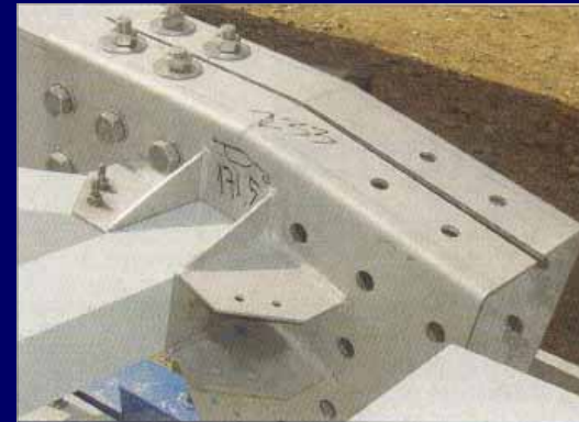
Ligações aparafusadas (aço inox)
