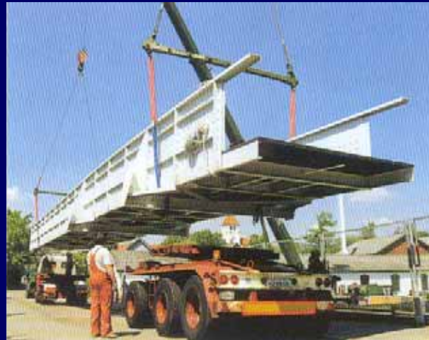
Transporte de um tramo de 27 m
