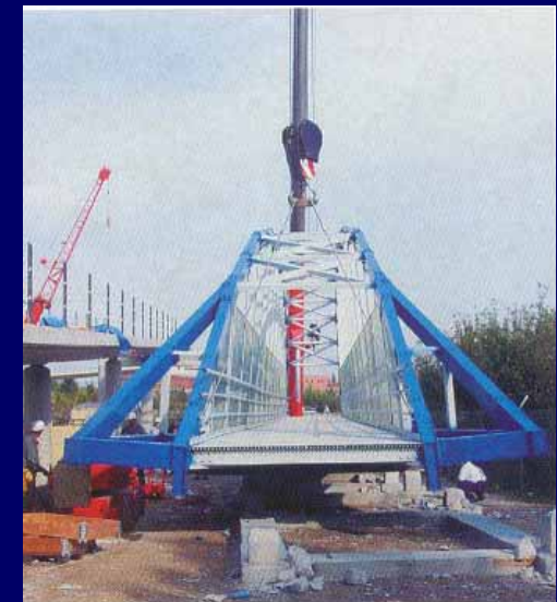
Elevação da ponte
