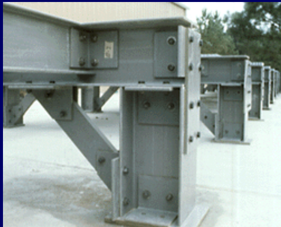
Ligações aparafusadas
