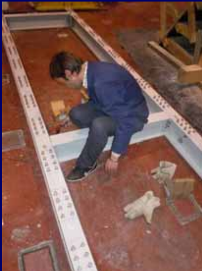
4. Montagem das vigas e contraventamentos
